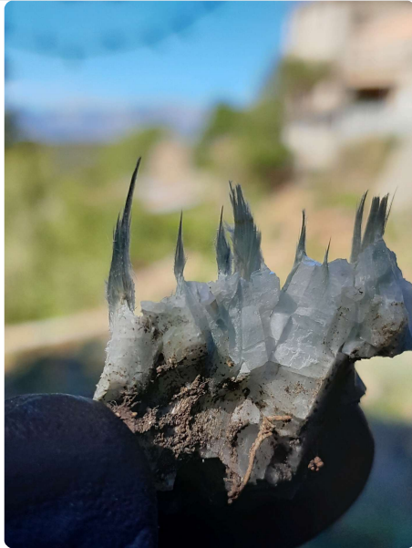
De l'actinolite amiante dans retrouvée lors de l'analyse d'un mur de soutènement à Focicchia en Haute-Corse - © Bureau GDA
